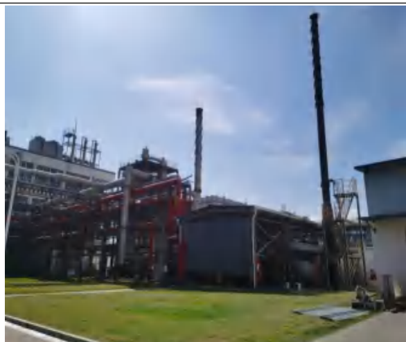
RTO、导热油炉锅炉废气排气筒
